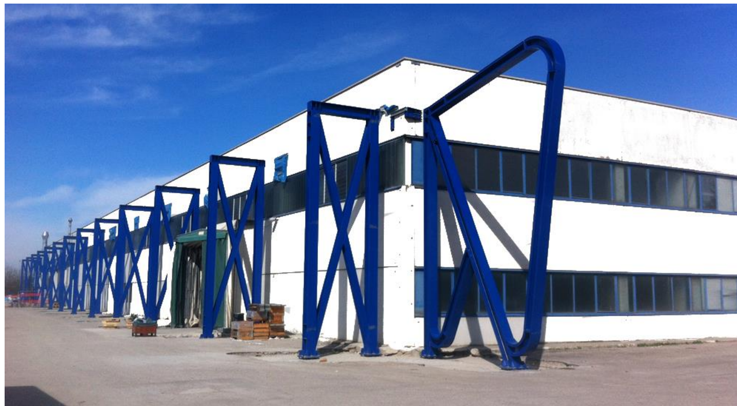
Realizzazione ultima del miglioramento sismico
