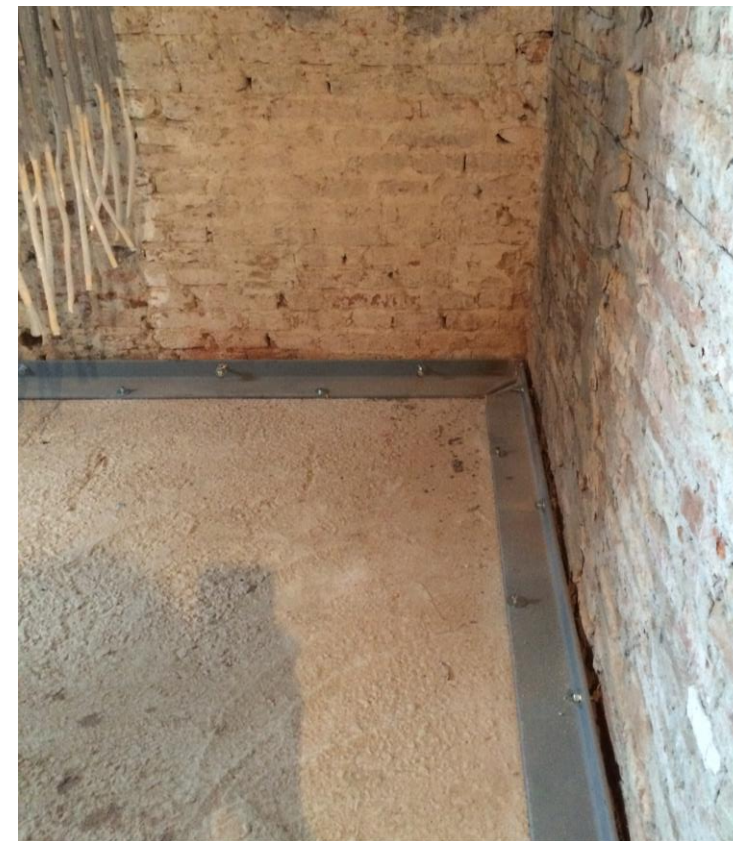
Angolare metallico - Realizzazione cordolo
