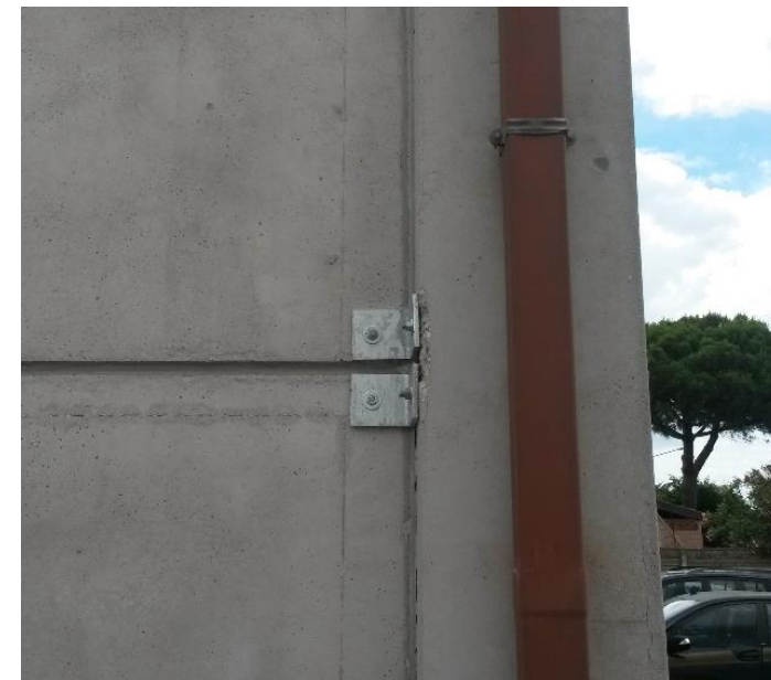
Collegamento pilastro-pannello
