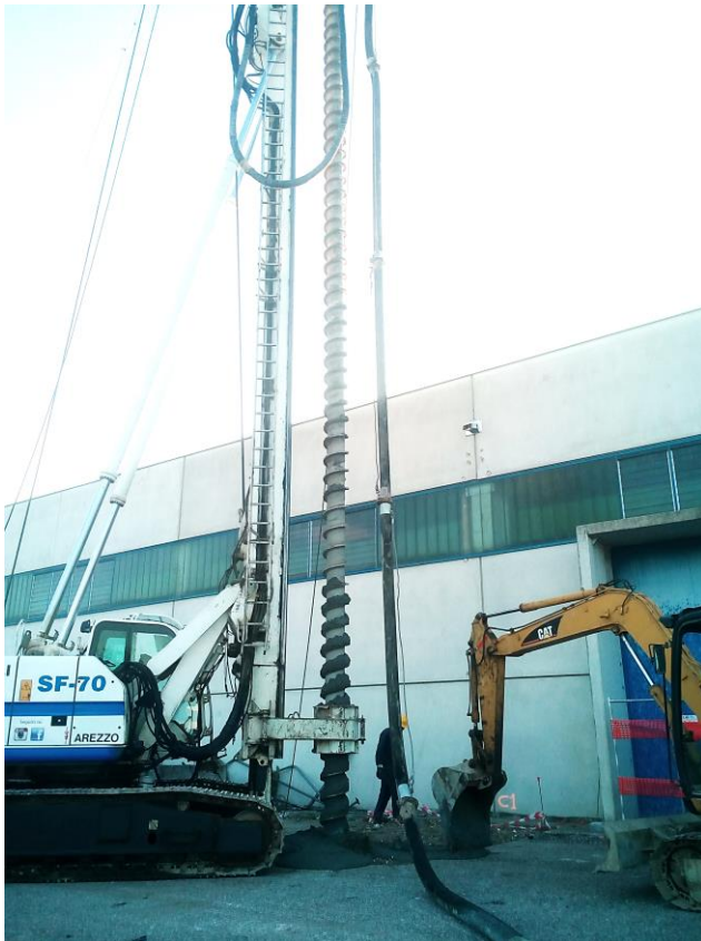
Trivellazione pali
