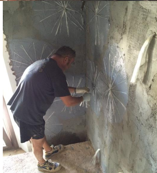
Rete GFRP e fiocchi -Rinforzo parete muraria
