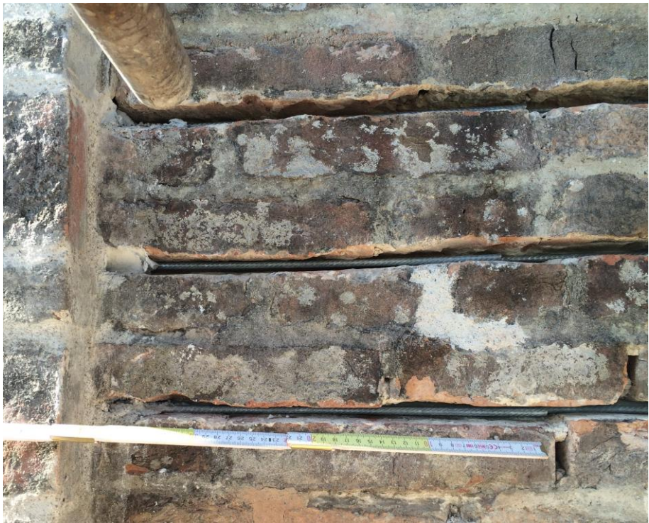
Ristilatura armata sulla faccia esterna della muratura - Rinforzo muratura
