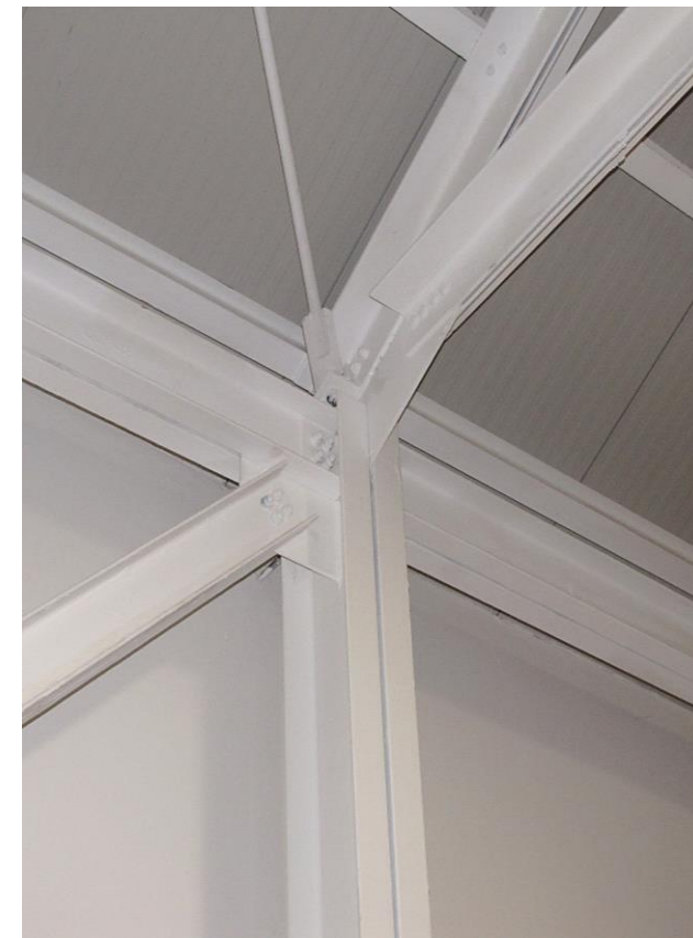
Nodo di collegamento
