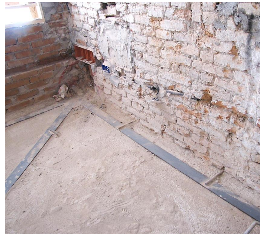
Irrigidimento solaio
