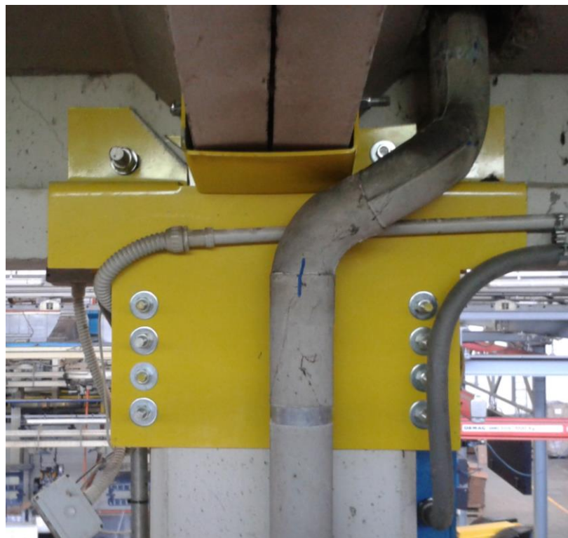
Collegamento pilastro-trave-tegolo
