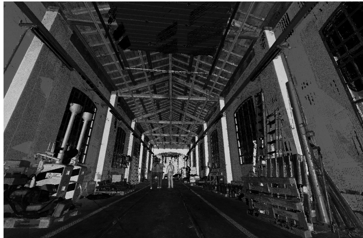
Interno acquisizione interferenze impianti
